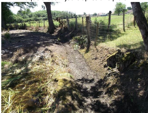
Collecteur sud au droit du bassin de décantation
